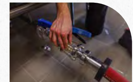
Die abgekühlte Würze wird in den Gärtank gepumpt
